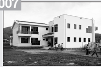
Neubau Schulhaus Vau i Dejes mit CHF 443'344.-
