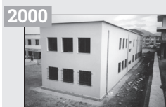
Neubau Schulhaus «I Qershori» Tirana mit CHF 226'070.-
