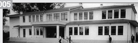
Neubau Schulhaus Shirq mit CHF 404'100.-
