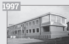
Renovation Kinder- garten Laç mit CHF 79'168.-
