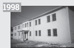
Renovation Kinderkrippe Nr. 48 Tirana mit CHF 70'580.-
